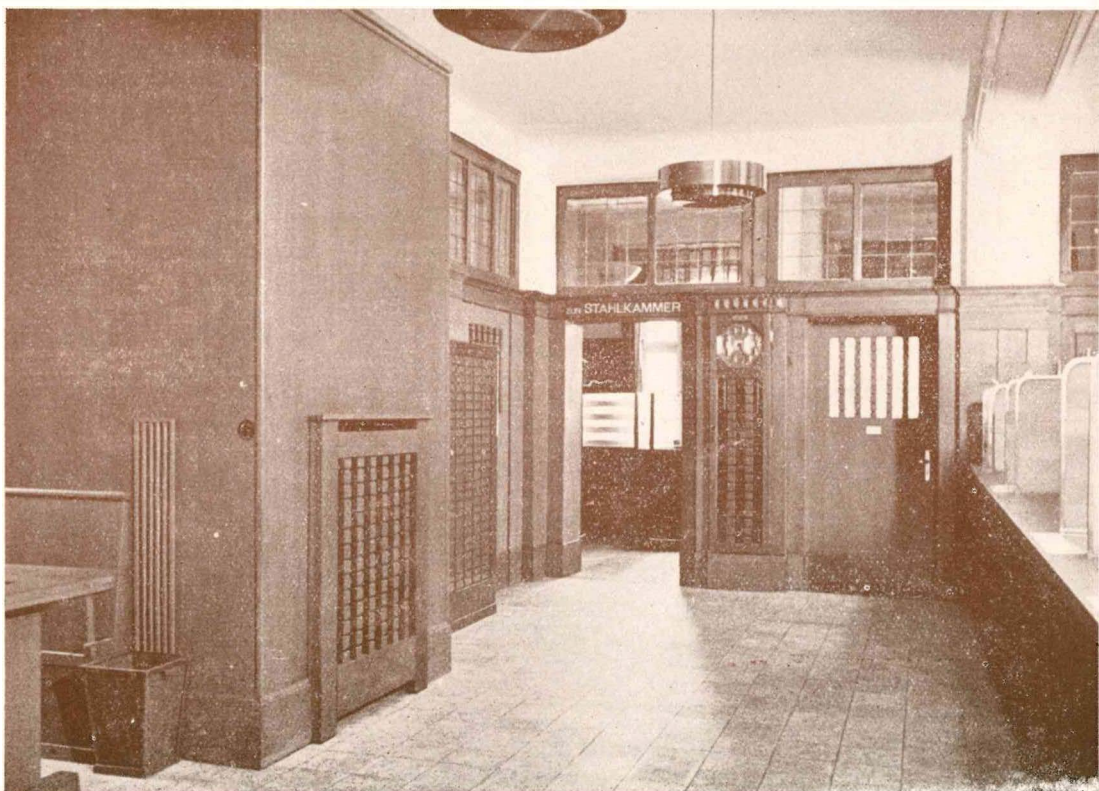
Blick zur Stahlkammer
